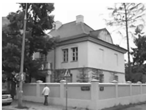
Fot. 1. Ogólny widok budynku K61 Photo 1. General appearance of building K61
