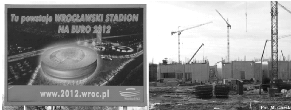
Fot. 1. Budowa stadionu miejskiego we Wrocławiu na Maślicach
