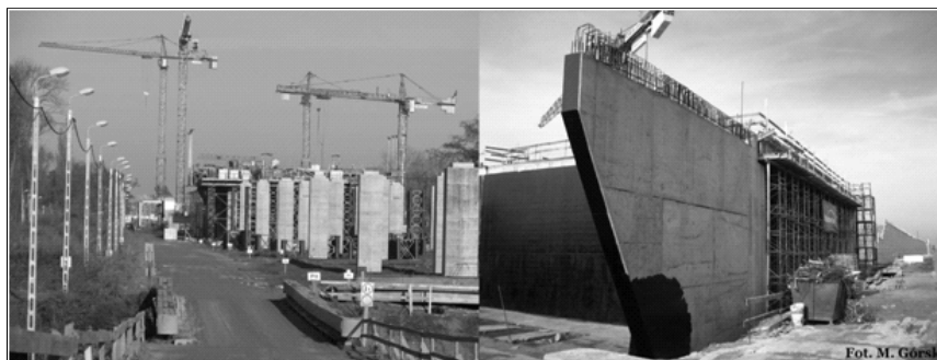
Fot. 2. Budowa Autostradowej Obwodnicy Wrocławia A8
