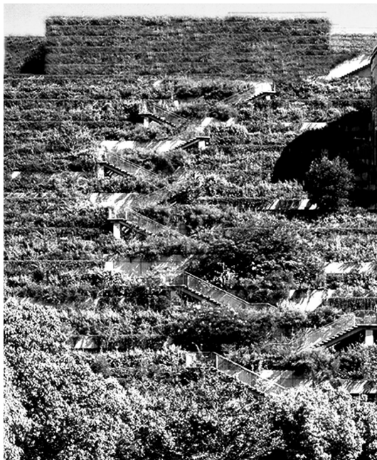
Fot. 8. Widok na zielone tarasy budynku Acros Fukuoka ( http://www.wayfaring.info/2009/06/11/acros-fukuoka-japan/ )
