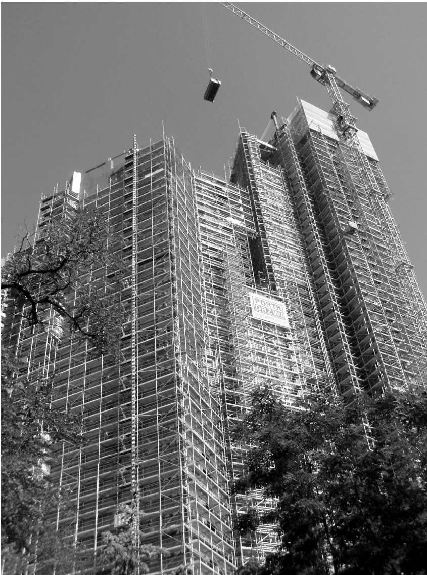
Fot. 1. Wieżowce Sea Towers w Gdyni podczas budowy (fot. M. Arczyńska)
