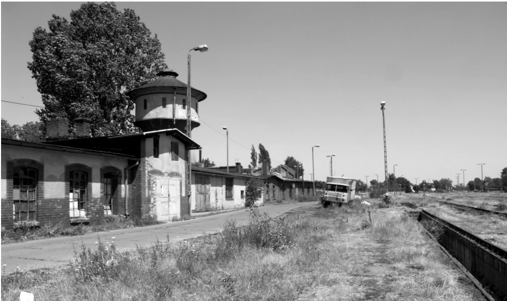
Fot. 2. Zdekapitalizowana zabudowa stanowi znaczną część infrastruktury kolejowej w Wielkopolsce i wymaga odnowy – przykład stacji w Wągrowcu (fot. M. Karnaś)
