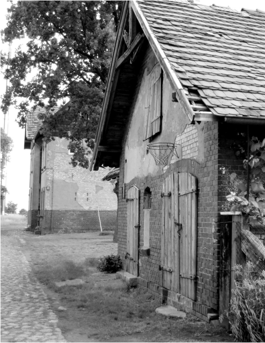
Fot. 1. Atrakcyjne pod względem architektury wielkopolskie stacje kolejowe w małych miastach stanowią niewykorzystany potencjał turystyczny regionu (fot. B. Kaźmierczak)
