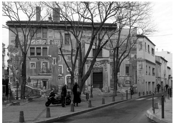
Fot. 4. Pomalowana fasada kamienicy, Place Fr. Jaumes, Montpellier (fot. B. Makowska)
