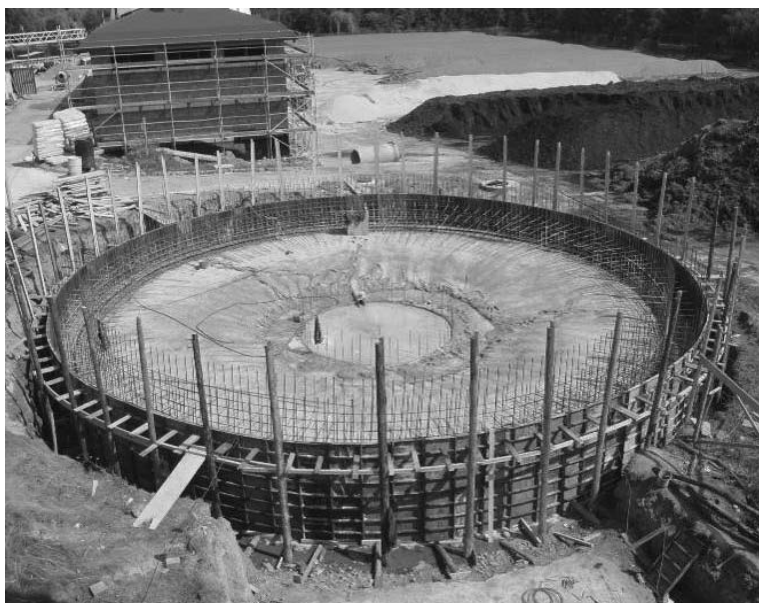
Rys. 4. Żelbetowa płyta fundamentowa komory WKF w trakcie realizacji
