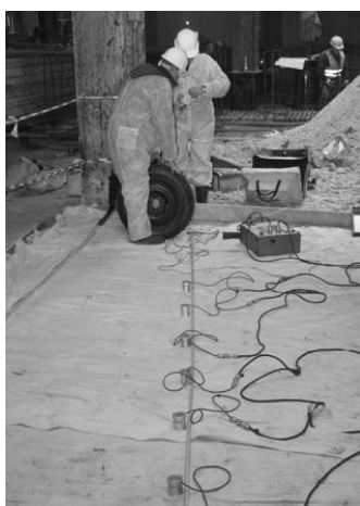
Rys. 14. Stawisko pomiarowe na dnie wykopu
