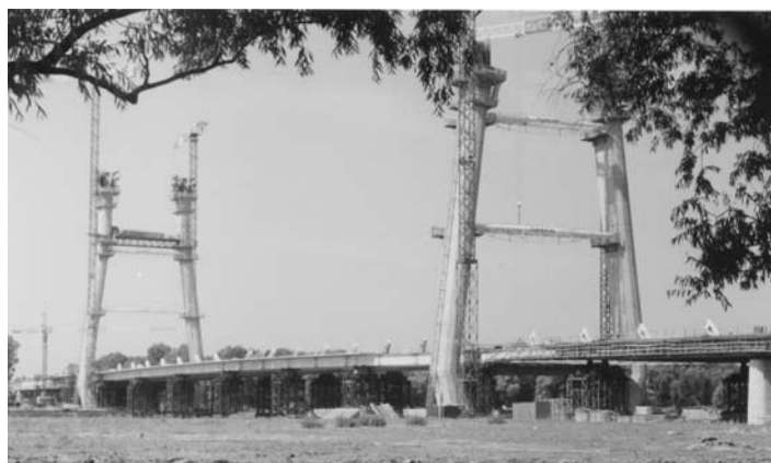
Rys. 3. Tymczasowe rozporry podczas budowy pylonu mostu Siekierkowskiego
