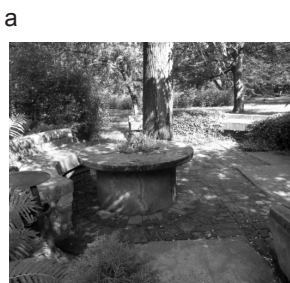
II. 5. Ogród w Żelazowej Woli; a – miejsce odpoczynku – siedziska wykonane z cegły, betonu i układanych na sztorc dachówek, blat stołu betonowy; b – altana ogrodowa z betonu (fot. A. Zachariasz, 2007)
