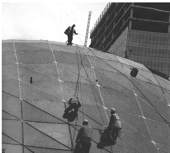
II. 6. Dach szklany w Warszawie „Złote Tarasy”. Zbliżenie (fot. A. Bojęś)
