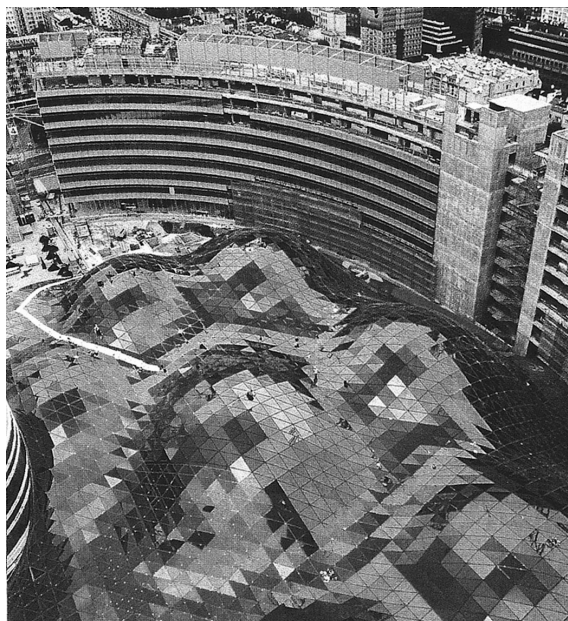
II. 5. Dach szklany w Warszawie „Złote Tarasy”. Konstrukcja kopulasta przeszklona płaskimi szybami. Całkowicie nowe ukształtowanie architektoniczne dachu szklanego ukształtowanego krzywiznowo (fot. A. Bojęś)
