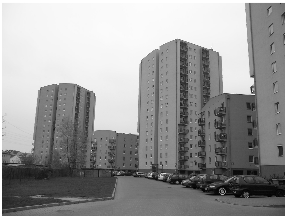
Il. 1. Sąsiedztwo budynków o bardzo różnych wysokościach (fot. T. Kusionowicz)
