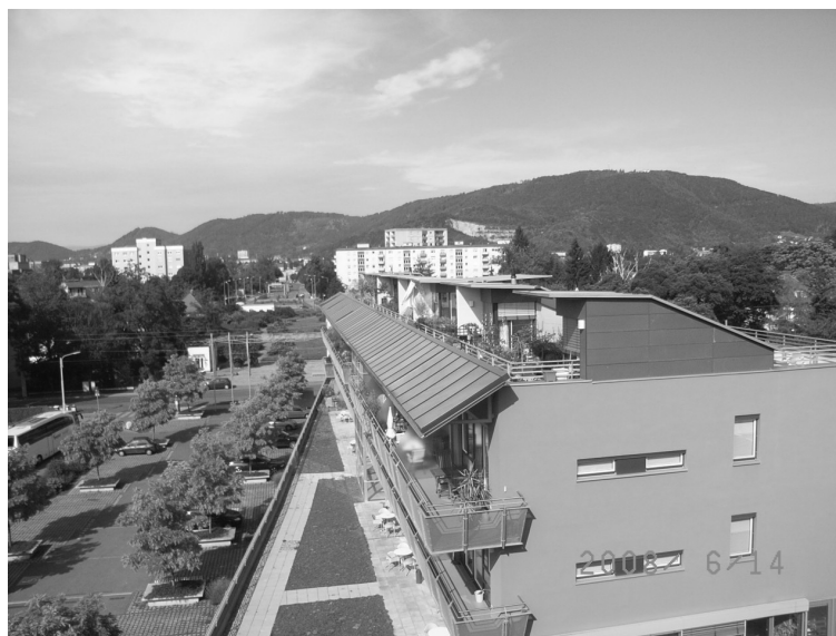
II. 2. Zespół mieszkaniowy „Theodor Korner Strasse” Graz. Elewacja południowa z kolektorami (fot. B. Majerska-Palubicka)
