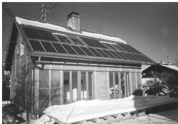
II. 4. Dom jednorodzinny, Steingaden, Niemcy. Arch. Architekturbüro Waterloo. Forma inspirowana stylem regionalnym z zastosowaniem współczesnych technologii uzyskiwania energii słonecznej (aktywnych – kolektory słoneczne na dachu, pasywnych – ściana słoneczna od strony południowej budynku zawierająca duże przeszklenia tradycyjne oraz przeszklenia z transparentną izolacją termiczną). Kierunek pośredni pomiędzy low- i high-tech : environmental humanism (źródło: www.architekt-waterloo.de )
