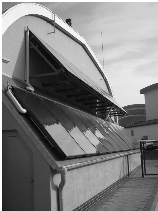
II. 4. Widok standardowych kolektorów na płd. elewacji hali łuczniczej
