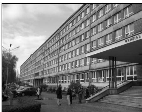
II. 1. Elewacja frontowa budynku przy ul. Konarskiego w Gliwicach
