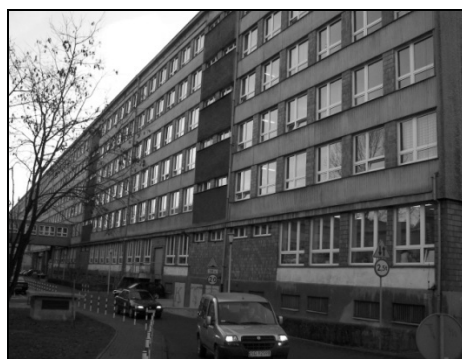
II. 2. Elewacja tylna budynku przy ul. Konarskiego w Gliwicach
