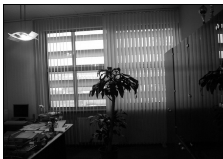
II. 5. Budynek Wydziału Prawa i Administracji – podwójne systemy żaluzji (wewnętrzne i zewnętrzne)
