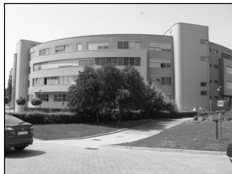
II. 4. Elewacja tylna budynku Wydziału Prawa i Administracji, Katowice
