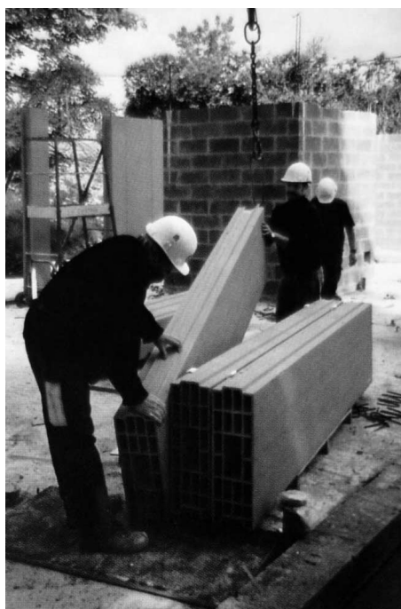
II. 6. Montaż bloczków ceramicznych (fot. Detail 04/2001)
