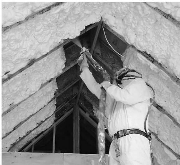
II. 4. Natrysk pianki poliuretanowej (fot. e-dach)
