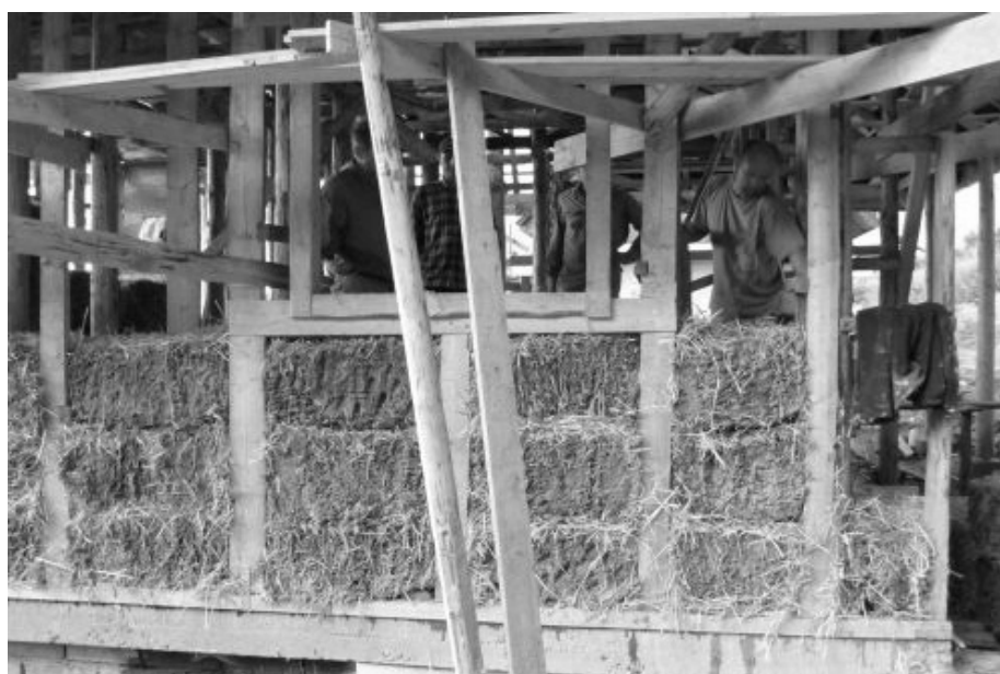
II. 3. Układanie bloczków słomy namoczonej w półpłynnej zawieszynie gliny, wody i piasku (źródło: www.biobudownictwo.org )
