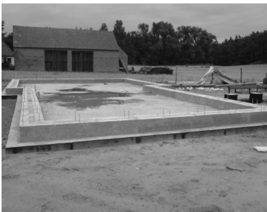
II. 1. Fundament pod budynek z „glinosłombeli” (źródło: www.biobudownictwo.org )
