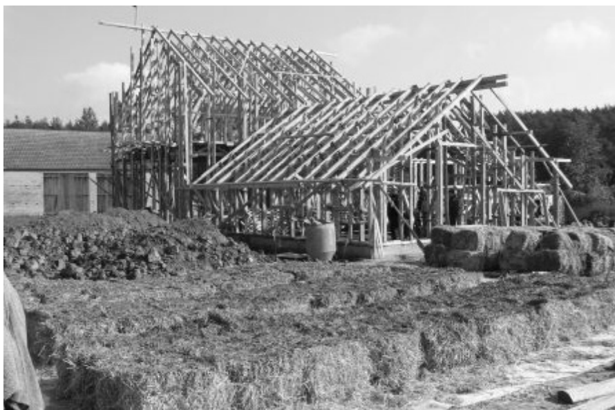
II. 2. Konstrukcja szkieletowa drewniana przed wypełnieniem bloczkami słomy (źródło: www.biobudownictwo.org )
