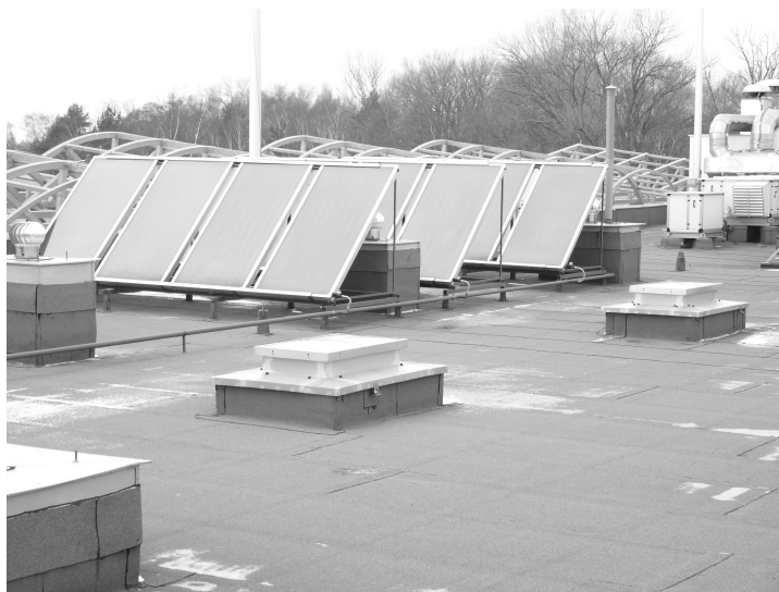
II. 9. NCŻ – Gdańsk Górki Zach. Fragment stropodachu z widokiem na pochyłe zestawy solarów i wyniesione osłony naświetli usytuowanych wzdłuż osi korytarza niższej kondygnacji. W głębi konstrukcja kratownic zadaszenia jeszcze bez pokrycia proj. płytami poliwęglanowymi (fot. G. Rzepecki)
