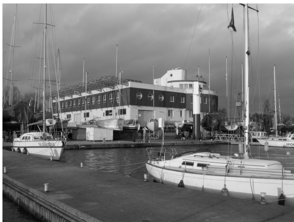
II. 3. NCZ Gdańsk Górki Zachodnie. Widok z pirsu na elewację zachodnią i południową. Poziome pasy podziału zróżnicowane materiałowo podkreślają zrównoważenie formalne i stabilność bryły (fot. G. Rzepecki)
