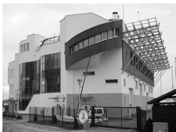
II. 2. Narodowe Centrum Żeglarstwa (NCŻ) Gdańsk–Górki Zachodnie. Widok narożnika północno-zachodniego po ukończeniu robót i wzbogaceniu bryły stalową konstrukcją wspornikową zadaszania przestrzeni przed bramami hangaru (fot. G. Rzepecki)
