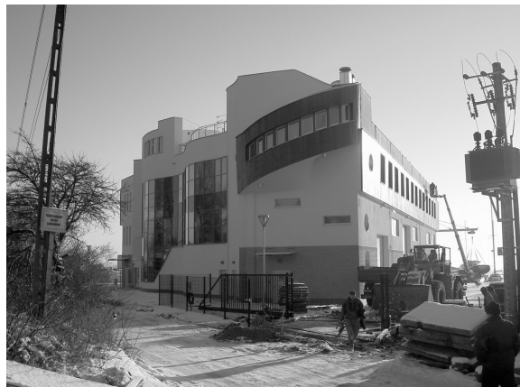
II. 1. Narodowe Centrum Żeglarstwa (NCŻ) Gdańsk–Górki Zachodnie. Widok (z okresu budowy) narożnika północno-zachodniego z kompozycją falujących form elewacji północnej w kontraście do jednolitych płaszczyzn elewacji zachodniej (fot. G. Rzepecki)
