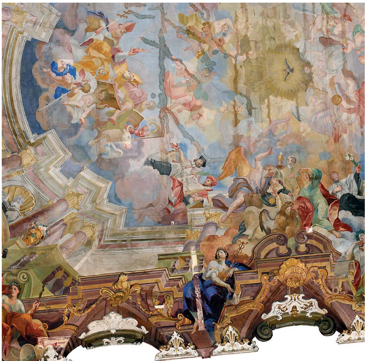
Ryc. 14. Uniwersytet Wrocławski, Aula Leopoldina; ortofotoplan barwny sklepienia – fragment: widoczne pociemnienie retusze w miejscach uzupełnień zaprawy, biegnące w formie pionowych pasów oraz sondy pasowe wykonane w trakcie prac badawczych Fig. 14. University of Wrocław, Aula Leopoldina; colour orthophotomap of the vault – fragment: visible darkened retouches in places where mortar was filled in, running as vertical stripes, and stripe probes made during research work
