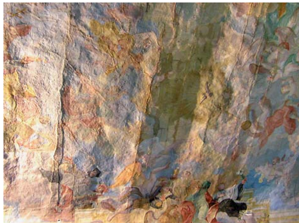
► Ryc. 3. Uniwersytet Wrocławski, Aula Leopoldina; fragment sklepienia nad audytorium – widoczne odkształcenia tynków z barokową dekoracją freskową. Fotografia w świetle bocznym, wyk. Ewa Skrzydlak, 2008
