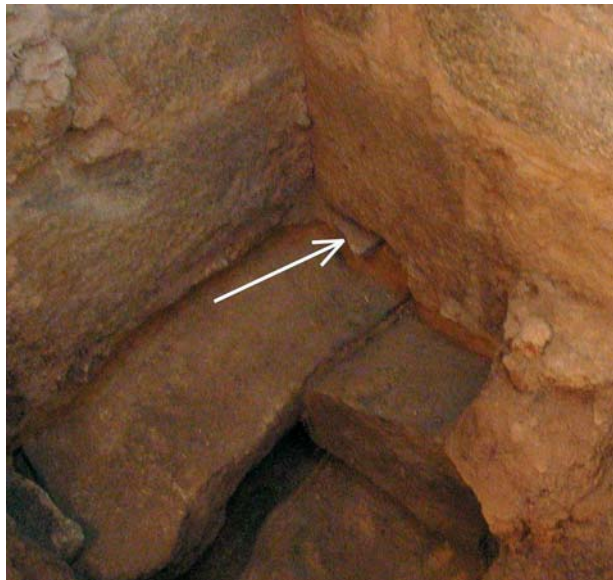
Ryc. 3. Pierwotny poziom użytkowy z prezbiterium z widocznym fragmentem płytki granitowej, narożnik północno-wschodni. Fot. K. Stala Fig. 3. Original utility level from the presbytery with a visible fragment of a granite tile, north-east corner. Photo: K. Stala
