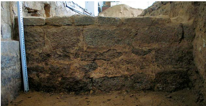
Ryc. 8. Widok na odsłonięte lico muru poprzecznego (tzw. Sala Rycerska). Fot. K. Stala Fig. 8. View onto the uncovered face of the crosswise wall (the so called Knight's Room). Photo: K. Stala
