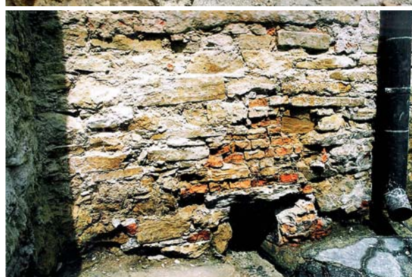
Ryc. 16. Wlot kanału odpływowego w ścianie północnej wirydarza; widok wlotu kanału po zbitiu tynku z elewacji oraz podczas kontynuacji prac remontowych. Fot. B. Kwiatkowska-Kopka, 2004 Fig. 16. Inlet of the drainage canal in the north wall of the garth; view of the canal inlet after hacking off plaster from the elevation and during the continuing renovation work. Photo B. Kwiatkowska-Kopka, 2004
