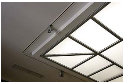
Ryc. 4. Fragment sufitu świetlnego z paneli poliwęglanowych Fig. 4. Fragment of a luminous ceiling from polycarbonate panels
