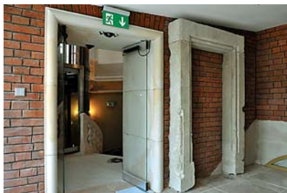
Ryc. 6. Nowe ościeże w przedsionku wyjścia na taras z neogotyckim ościeżem Prylińskiego Fig. 6. New jamb in the porch to the terrace with a neo-Gothic jamb by Pryliński
