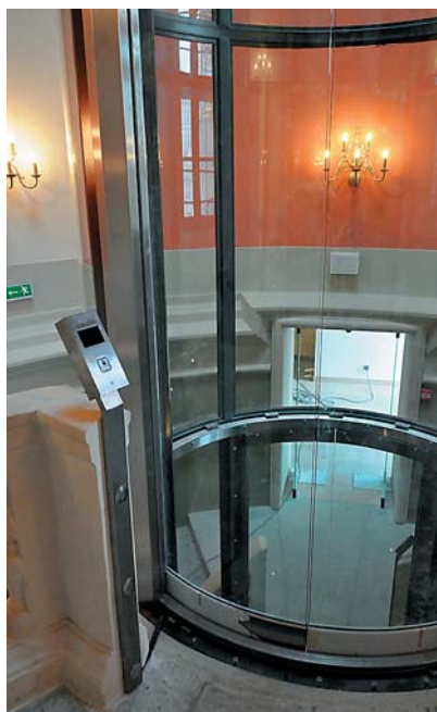
Ryc. 13. Przystanek końcowy windy panoramicznej na poziomie sal wystawowych Fig. 13. End stop of the panoramic lift at the level of exhibition rooms
