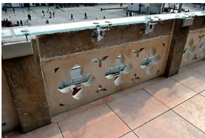
Ryc. 1. Balustrada i fragment podłogi dystansowej tarasu dla publiczności Fig. 1. Balustrade and a fragment of a raised floor of the viewing terrace for the public
