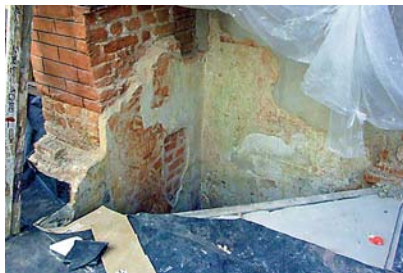
Ryc. 10. Odkryte renesansowe fragmenty polichromii zdobiącej ściany nieistniejącego domu kupieckiego Fig. 10. Uncovered Renaissance fragments of the polychrome decorating the walls of a non-existent merchant house
