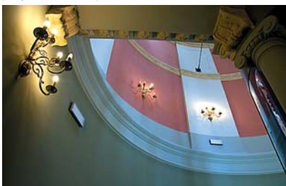
Ryc. 5. Nowa kolorystyka klatki schodowej odтворzona na podstawie badań stratygraficznych Fig. 5. New colour scheme of the staircase recreated on the basis of stratigraphic research
