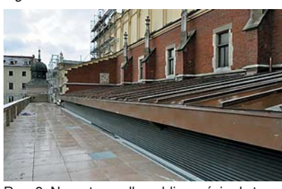
Ryc. 9. Nowy taras dla publiczności od strony wschodniej Fig. 9. New terrace for the public on the east side
