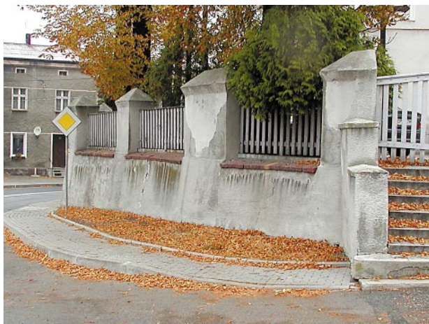
Ryc. 7, 8. Pęknięcia i ślady silnych zawilgoceń muru oporowego okalającego skarpy Fig. 7, 8. Cracks and traces of damp patches on the retaining wall surrounding the escarpment
