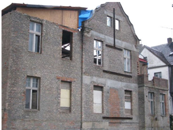
Rys. 9. Elewacja tylna w trakcie remontu – porównaj z rys. 2 Fig. 9. Back elevation during repair (compare with Fig. 2)
