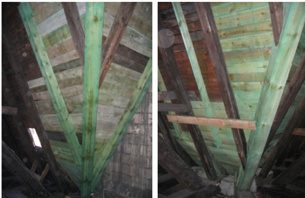
Rys. 2. Wymienione krokwie koszowe Fig. 2. Replaced valley rafters
