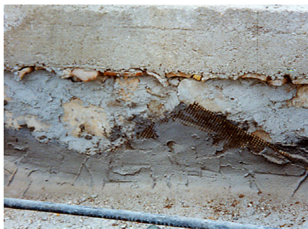
Preparation of vault's surface Przygotowanie powierzchni sklepienia
