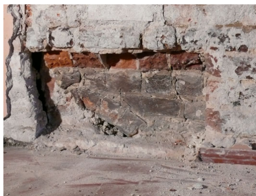
Rys. 2. Fragment profilowanego obramienia otworu wejściowego w elewacji wschodniej kamienicy Dzierżonia 10. Foto A. Peszko
