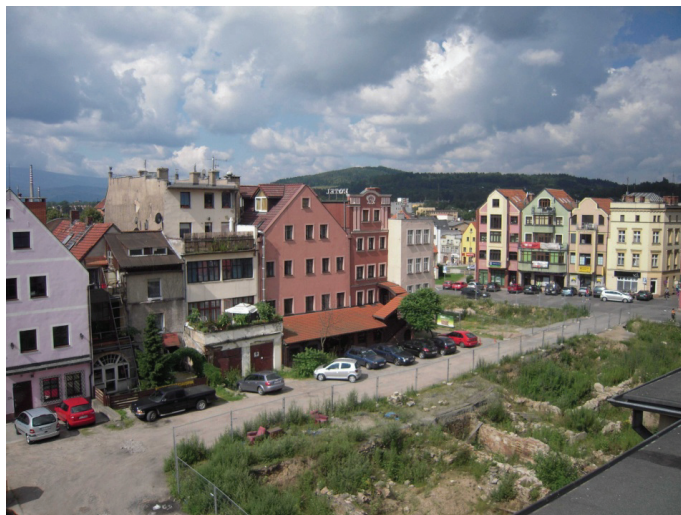
Rys. 1. Widok ogólny terenu projektowanego wykopu i sąsiadujących budynków Fig. 1. General view of excavation area and surrounding buildings
