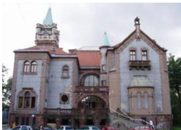
Rys. 3. Widok elewacji północnej Fig. 3. North facade
