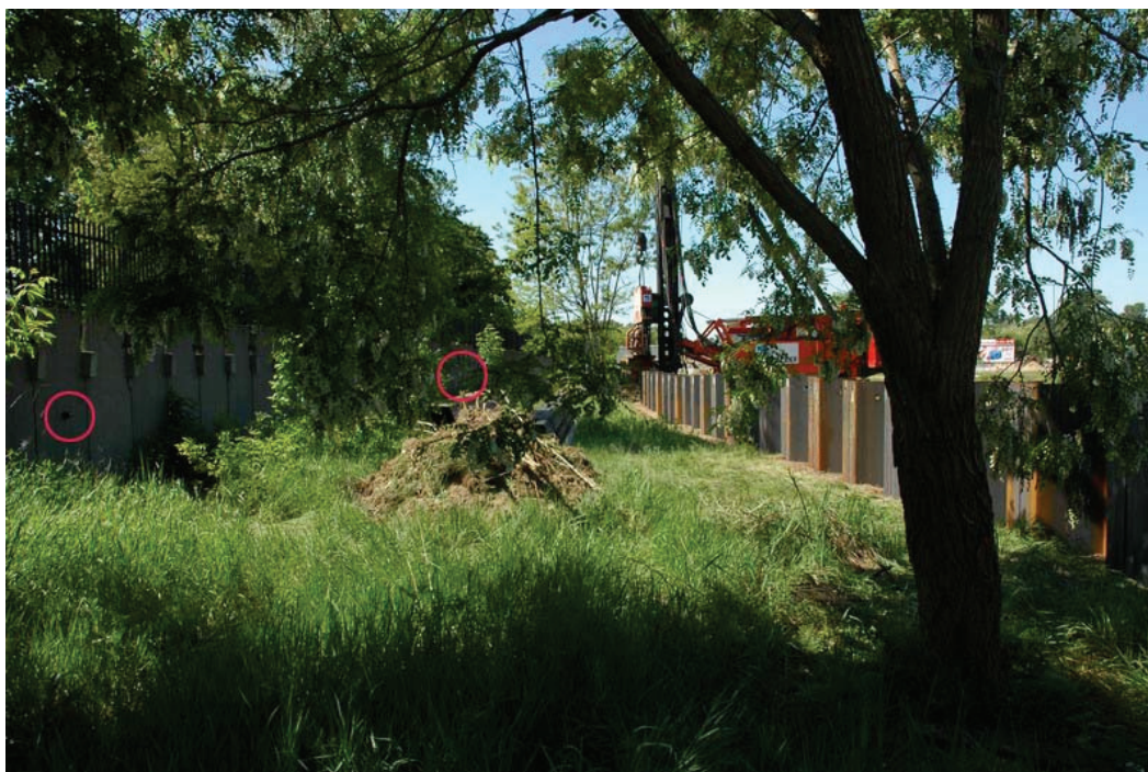
Rys. 4. Obserwacja drgań na ogrodzeniu cmentarza. Lokalizacja czujników drgań Fig. 4. Monitoring of vibrations on the cemetery wall – sensor locations
