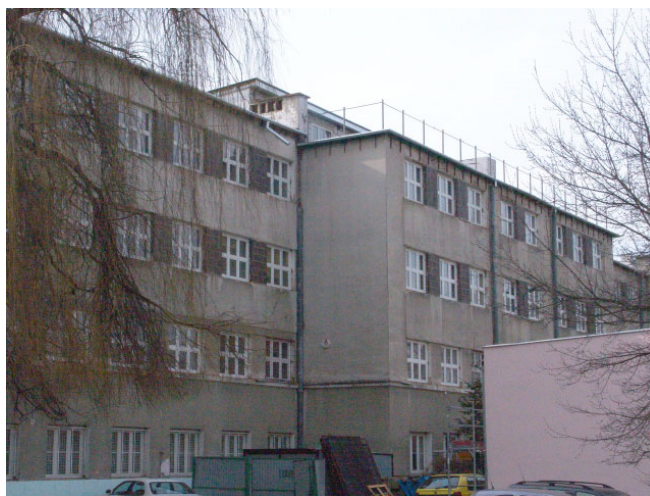
Rys. 8. Widok szkoły w Lublinie przed i po dociepleniu (fot. autor) Fig. 8. A view of school in Lublin, before and after insulation works (photo by author)
