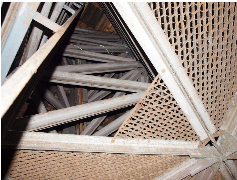
Rys. 8. Słup sercowy hełmu Fig. 8. Central pillar
