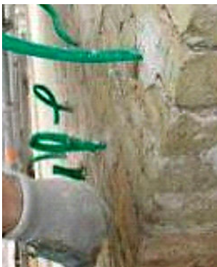
Fig. 8. Strengthening interventions using mortar grouting Rys. 8. Interwencje wzmacniające z zastosowaniem zastrzyku (iniekcji) zaprawy murarskiej
