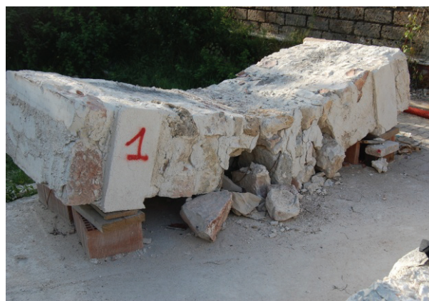
Fig. 8. Failure of panel 1 Rys. 8. Zniszczenie płyty 1
