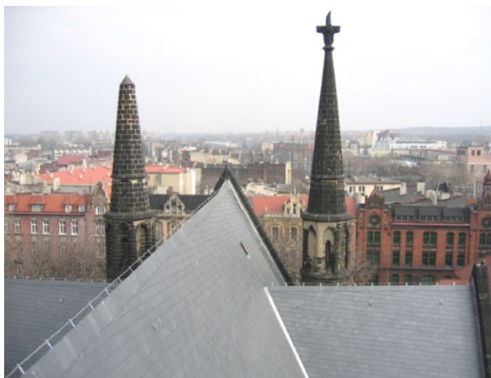
Rys. 3. Wymienione pokrycie dachu Fig. 3. The new roofing
