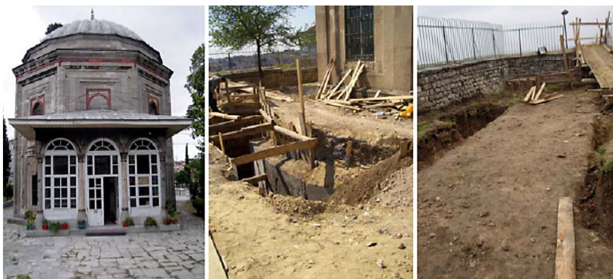
Fig. 10. Retaining wall of the tomb at Yavuz Selim Mosque Rys. 10. Ściana oporowa grobowca w meczecie Yavuz Selim
