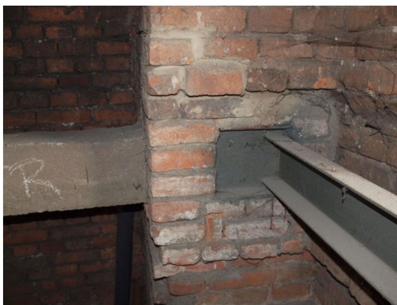
Rys. 4. Wzmocnienia murów Fig. 4. Strengthening of the walls
