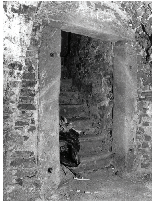
Rys. 5. Odkryte w 1991 r. oryginalne schody i wejście do krypty. Fot. J. Doraczek, ze zbiorów WKZ w Krakowie
