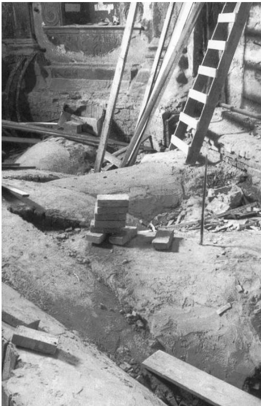
Rys. 9. Widok fragmentu odtworzonego sklepienia nad kryptą grobową od góry kaplicy Morstinów. Fot. A.J. Gaczoł, 1991 Fig. 9. The view of the fragment of the reconstructed vault over the sepulchral crypt as seen from the top of the Morstins' chapel. Photo by A.J. Gaczoł, 1991
