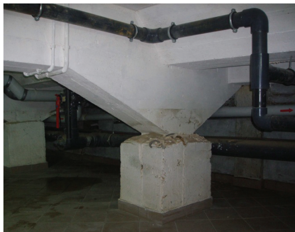
Rys. 3. Widok podciągu i cokołu wsporczoego Fig. 3. Bearing main beams and pedestals
