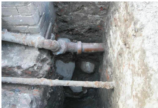
Rys. 12. Odkrywka fundamentu w narożu Fig. 12. View of foundation pit in corner
