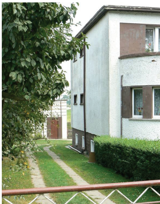
Rys. 10. Czujnik na budynku mieszkalnym Fig 10. Sensor on the residential house
