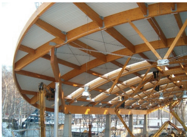
Rys. 1. Pierwszy obiekt w Polsce z podciągami wzmocnionymi taśmami AFRP
