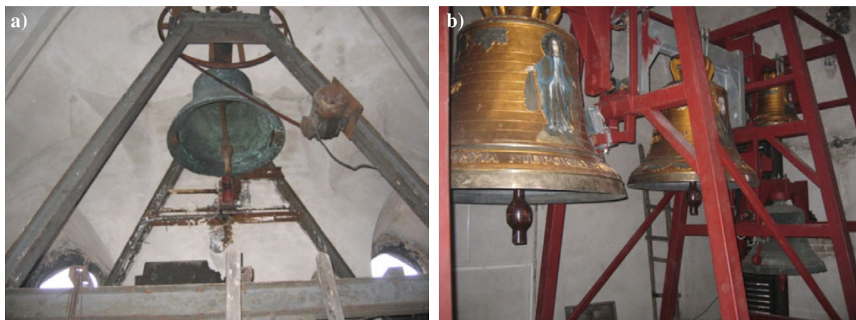
Rys. 7. Stary dzwon (a) i nowe dzwony na nowej konstrukcji kozłowej (b) Fig. 7. The old bell (a) and the new bells on the new supporting structure (b)
