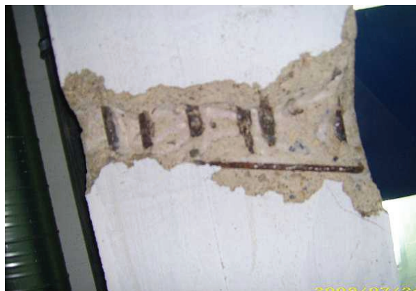
Rys. 11. Zbrojenie podciągu Fig. 11. Main beam reinforcement
