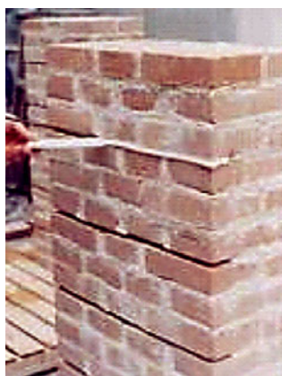
Fig. 15. (a) Reinforced repointing using FRP laminates. FE modelling of masonry wall strengthened with FRP bars (b) and (c); [8] Rys. 15. (a) Wzmocnione punktowe naprawy przy użyciu laminatów FRP. Modelowanie FE murowanej ściany wzmocnionej prętami FRP (b) i (c); [8]
