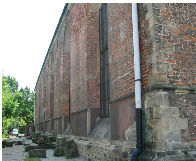
Rys. 11. Widok ściany podłużnej kościoła Fig. 11. View of longitudinal wall of church
