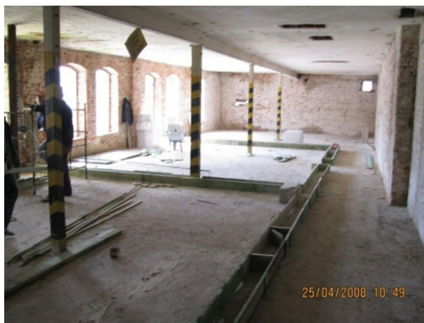
Rys. 1. Budynek poprzemysłowy w Rawiczu przed montażem ścian z bloków gipsowych
