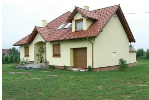
Rys. 7. Monitorowany nowy budynek Fig. 7. Monitored new building
