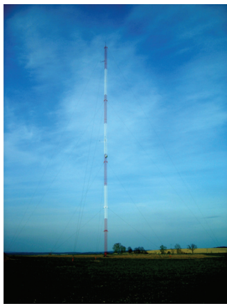
Rys. 1. Widok ogólny obiektu badań Fig 1. A general view of the mast
