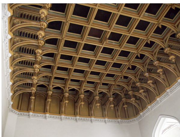
Rys. 7. Strop kasetonowy nad salą reprezentacyjną na I piętrze Fig. 7. The coffered ceiling over the stately hall on the 1 st floor
