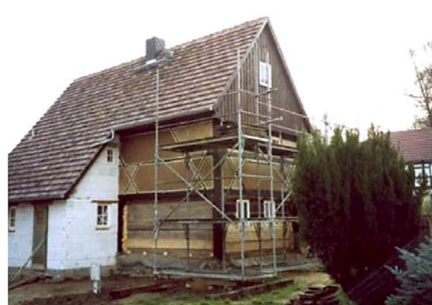
Rys. 5. Translokacja domu w miejscowości Schönau-Berzdorf: u góry fazy przeniesienia szkieletu budynku, budynek w trakcie wykończenia – u dołu (fot. www.umgebnde.de za zgodą)
