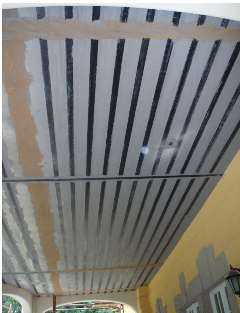
Rys. 8. Taras wschodni – widok doklejących taśm węglowych Fig. 8. East terrace – view of CFRP tapes
