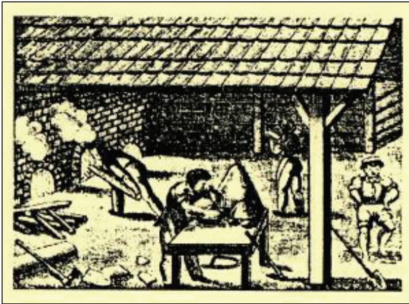
Rys. 3. Średniowieczna cegielnia. J. Gimpel „Jak budowano w średniowieczu”, W-wa 1968, repr. I. Płuska Fig. 3. Medieval brickyard J. Gimpel „Jak budowano w średniowieczu”, Warszawa 1968; photo I. Płuska
