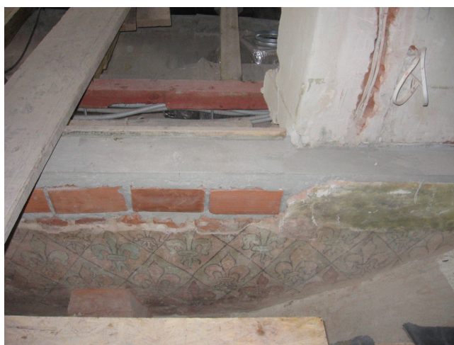
Rys. 1. Odkrytki gotyckich tynków i dekoracji malarskich Fig. 1. Uncovered Gothic plasters and painted decorations
