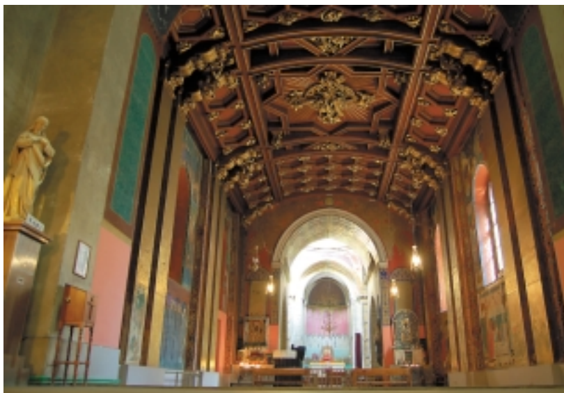
Ryc. 4. Podwieszony łukowy sufit z kasetonami (projekt F. Mączyńskiego) Fig. 4. Suspended arched coffered ceiling (designed by F. Mączyński)
