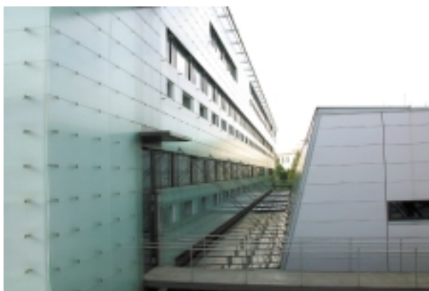
Ryc. 4. Fragment fasady wschodniej Fig. 4. A fragment of the eastern facade
