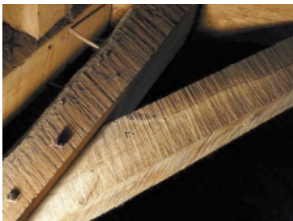
Ryc. 7. Ślady po pile ręcznej (fot. S. Cramer) Fig. 7. Traces of a handsaw (photo S. Cramer)
