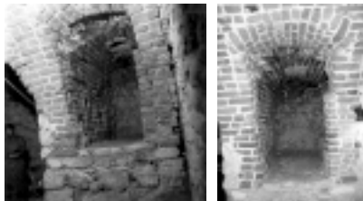
Ryc. 12. Klasztor augustianów w Krakowie, piwnica skrzydła wschodniego, widok ściany południowej pieca z otworem wlotowym. Fot. archiwalna T. Szklarczyk 1989; fot. stanu obecnego A. Bojęś-Białasik, 2009 Fig. 12. Augustinian monastery in Krakow; cellar of the east wing, view of the south wall of the stove with the inlet. Photo: archive, T. Szklarczyk 1989, photo of the present state by A. Bojęś-Białasik, 2009
