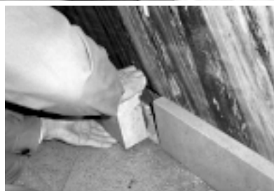
Ryc. 16. Rekonstrukcja oblicowania cokołu kamieniem – piaskowcem Fig. 16. Reconstruction of the pedestal sandstone facing
