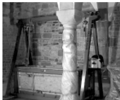
Ryc. 8. Zabezpieczony sarkofag i zmontowana konstrukcja nośna Fig. 8. Secured sarcophagus and assembled lifting construction
