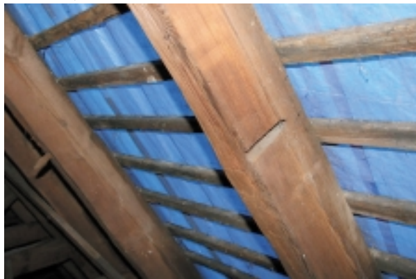
Ryc. 6. Ślady po rozszczepianiu drewna (fot. D. Mączyński)
