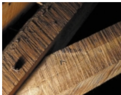
Ryc. 20. Ślad po piłę ręcznej Fig. 20. Traces of a handsaw
