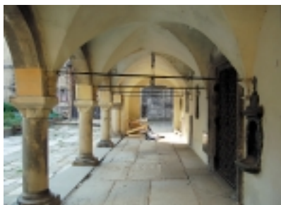
Ryc. 3. Podcienia arkadowe od strony południowej dobudowane w XV wieku Fig. 3. Arcaded gallery from the south, added in the 15 th century
