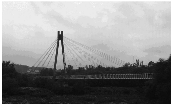
Rys. 1. Ogólny widok monitorowanego mostu podwieszanego
