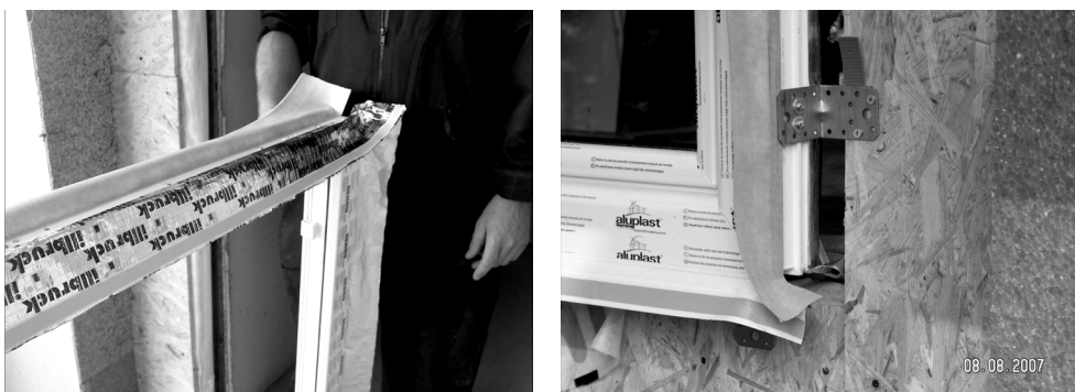
Fot. 7. Montaż folii na stolarce (fot. – M. Basińska) Photo 7. Assemble of insulating foil on window-frame (photo by M. Basińska)
