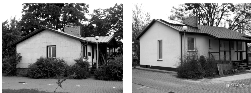
Fot. 1. Budynek doświadczalny przed termomodernizacją i po termomodernizacji (fot. – G. Matuszczak)
