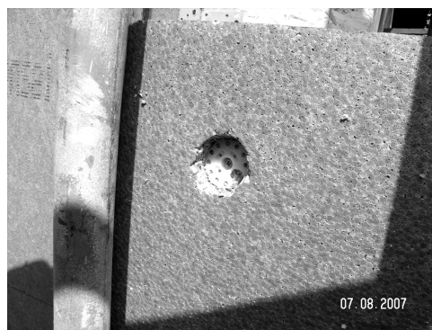
Fot. 4. Punktowy montaż płyt styropianowych (fot. – G. Matuszczak)
