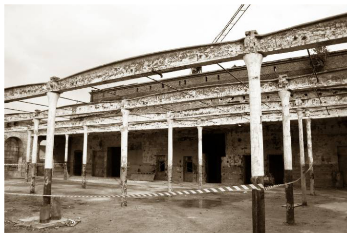
Rys. 5. Szkielet konstrukcji piątej kondygnacji Fig. 5. Skeleton of the structure of the fifth floor
