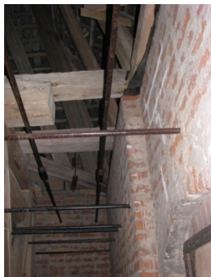
Rys. 8. Ściagi spinające ściany wieży (wklejane w mury).
