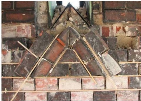
Rys. 13. Przemurowania odspojeń warstwy licowej Fig. 13. Re-bricklaying of the splitting off the facade layer
