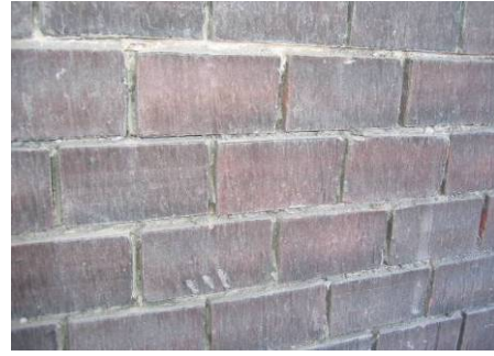
Rys. 12. Usuwanie wtórnego spoinowania zaprawą cementową Fig. 12. Taking off the secondary layer of cement mortar
