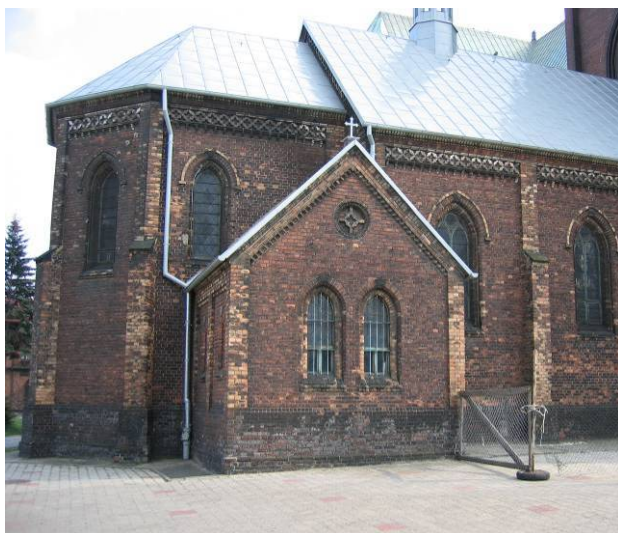
Rys. 6. Uszkodzenia korozyjne cegły kaplicy Świętego Aleksandra P.M. a) widok uszkodzonych ścian kaplicy b) szczegół uszkodzeń
