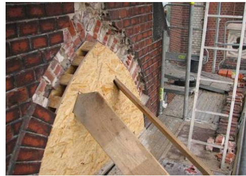
Rys. 13. Przemurowania odspojeń warstwy licowej Fig. 13. Re-bricklaying of the splitting off the facade layer
