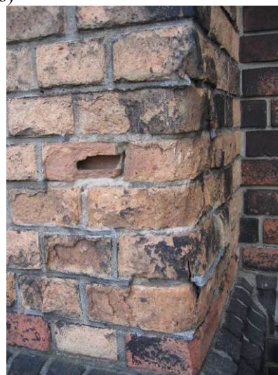
Rys. 6. Uszkodzenia korozyjne cegły kaplicy Świętego Aleksandra P.M. a) widok uszkodzonych ścian kaplicy b) szczegół uszkodzeń
