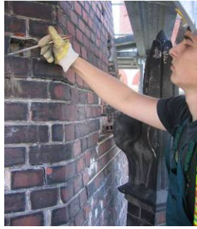
Rys. 12. Usuwanie wtórnego spoinowania zaprawą cementową Fig. 12. Taking off the secondary layer of cement mortar
