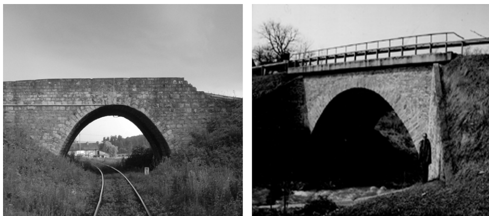
Rys. 1. Wiadukt drogowy w Zaborowie-Czudcu (z lewej) oraz most w Kamienicy Dolnej
