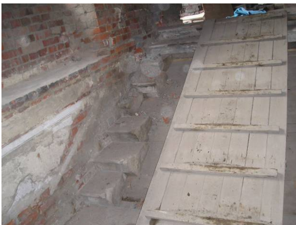
Rys. 11. Widok pozostałości stopni przy ścianie północnej.
