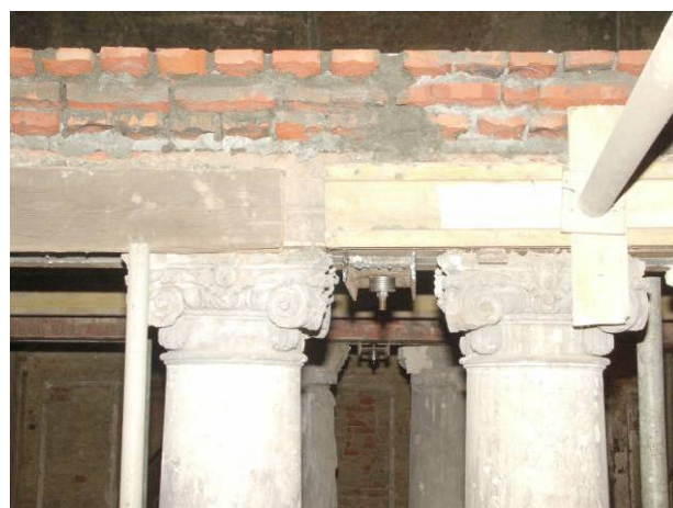
Rys. 23. Widok śrub wymuszających początkowe ugięcie elementów wzmacniających.
