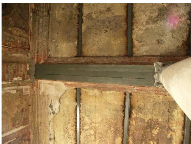
Rys. 22. Widok stropu od dołu po wzmocnieniu stalowych belek i podciągów.
