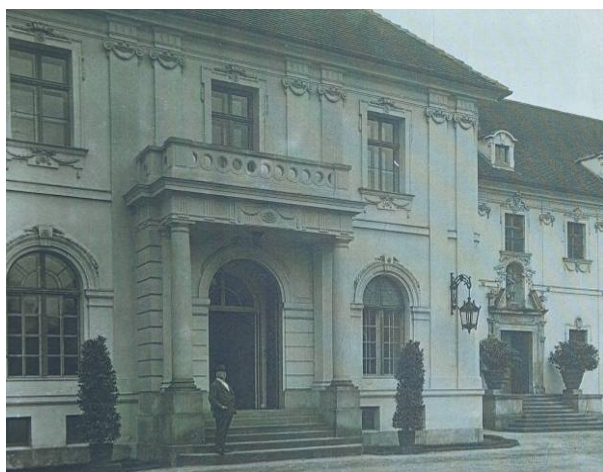
Rys. 5. Widok paradowej klatki schodowej w okresie po I wojnie światowej.
