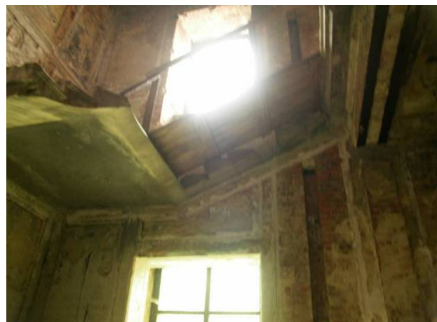
Rys. 12. Widok biegu przy ścianie północnej.
