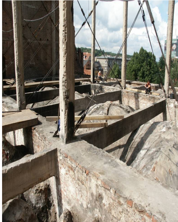
Rys. 4. Widok sklepień szkieletu żelbetowego nawy środkowej.
