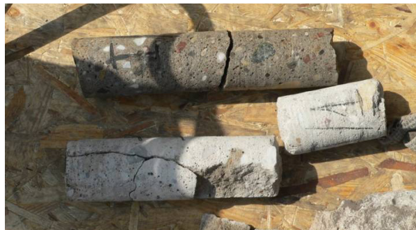
Rys. 5. Wewnętrzne pęknięcia betonu elementów żelbetowych stwierdzone na odwiertach pobranych do badań laboratoryjnych (fot. A. Radzicki).
