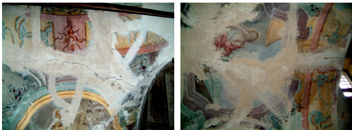
Rys. 9. „Naprawy” sklepień z wykorzystaniem zaprawy cementowej.
