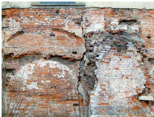
Rys. 4. Zniszczenia murów spowodowane przebudowaniami, rozbiórkami i działaniami wojennymi:
