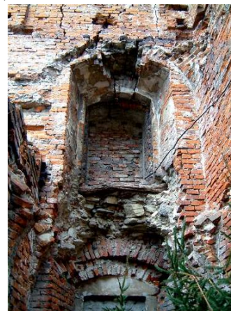
Rys. 4. Zniszczenia murów spowodowane przebudowaniami, rozbiórkami i działaniami wojennymi:
