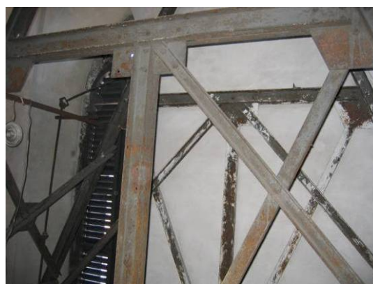
Rys. 5. Uszkodzenia korozyjne istniejącej stalowej konstrukcji wsporczej dzwonu.
