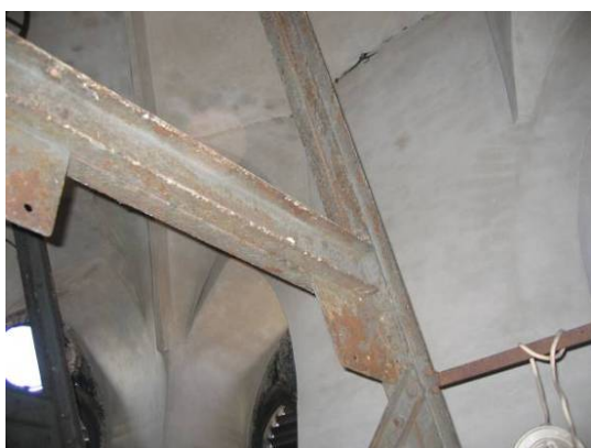
Rys. 5. Uszkodzenia korozyjne istniejącej stalowej konstrukcji wsporczej dzwonu.
