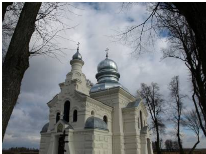
po naprawie after repair
