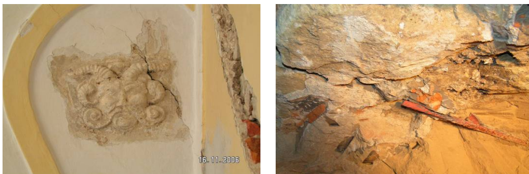
Rys. 4. Klasztor Dominikanów w Lublinie - przykład iniekcji wzmacniających z wykorzystaniem zaprawy OXAL VPIT.
