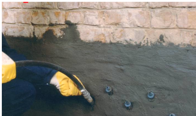
Rys. 2. Aplikacja preparatu hydrofobizującego w konstrukcję murową.
