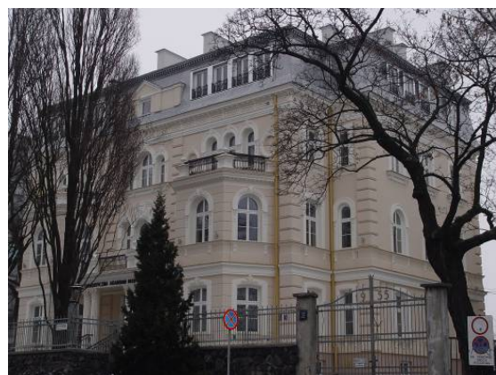
po naprawie after repair
