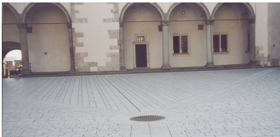
Rys. 7. Łączenie różnych elementów kamiennych nawierzchni Dziedzińca Wawelskiego po przebudowie (fot. P. Czerski)
