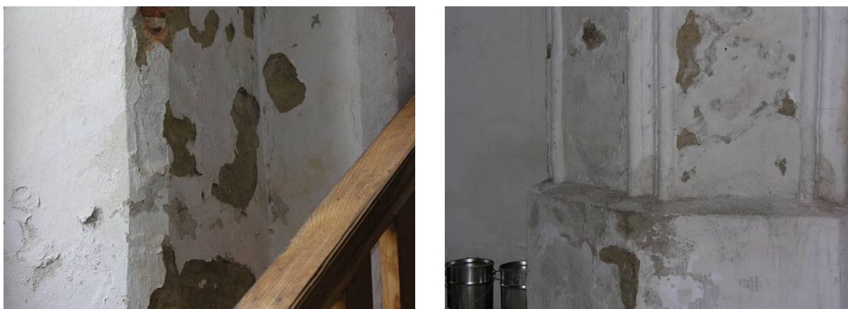
Rys. 3. Widok zawilgoconych ścian i filarów wewnątrz kościoła.
