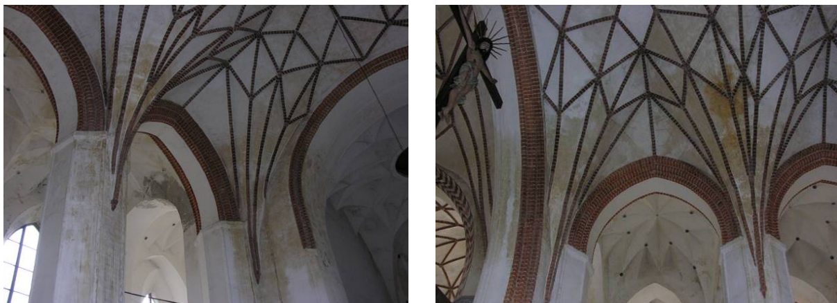
Rys.4. Widok powierzchni sklepień w nawie głównej i nawie bocznej kościoła.
