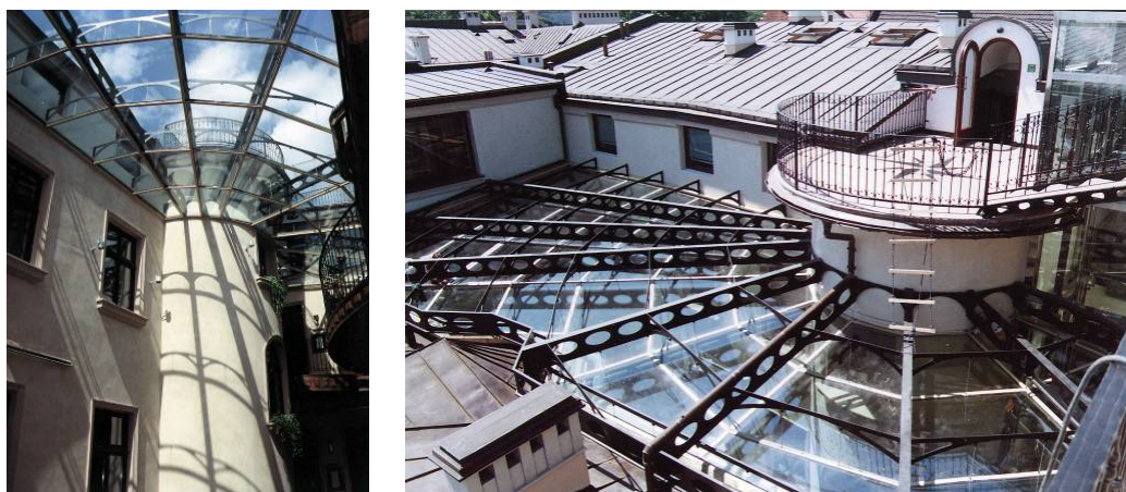
Rys. 6. Dach przeszklony nad dziedzińcem - po lewej konstrukcja stalowa przekrycia; po prawej widok dachu od strony wnętrza.
