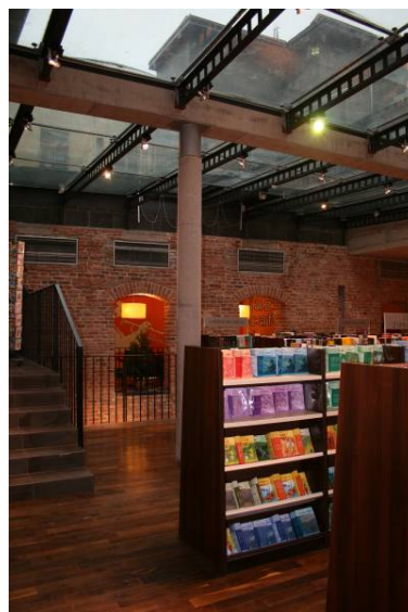
Rys. 16. Fragmenty zachowanych arkad i konstrukcja świetlika – Rynek Główny 12 Fig. 16. Fragments of preserved arcades and skylight structure (Market Place 12)
