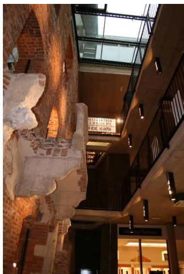
Rys. 16. Fragmenty zachowanych arkad i konstrukcja świetlika – Rynek Główny 12 Fig. 16. Fragments of preserved arcades and skylight structure (Market Place 12)
