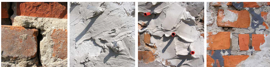
Rys. 8. Kolejne etapy naprawy pęknięcia Fig. 8. The sequence of cracks repair
