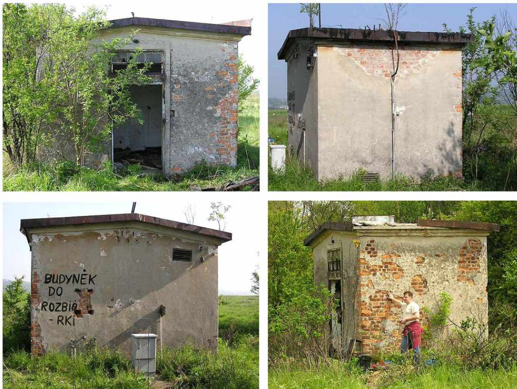
Rys. 5. Widok badanego budynku stacji trafo w stanie nieuszkodzonym Fig. 5. View of the tested masonry building in undamaged condition
