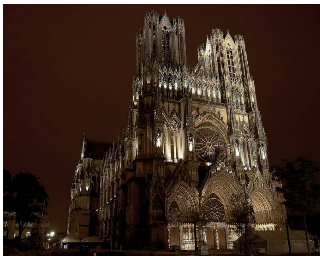
Fot. 2. Iluminacja katedry w Reims
