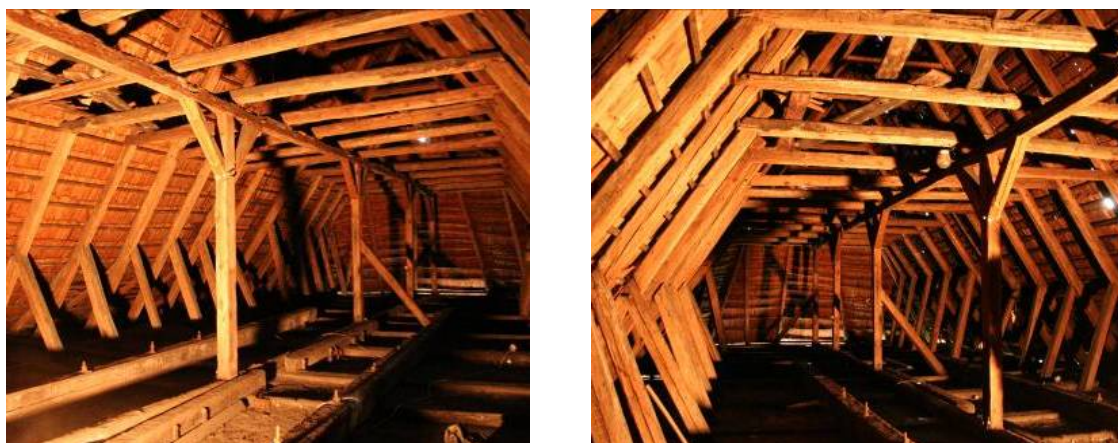
Rys. 8. Widoki wieżby dachowej
