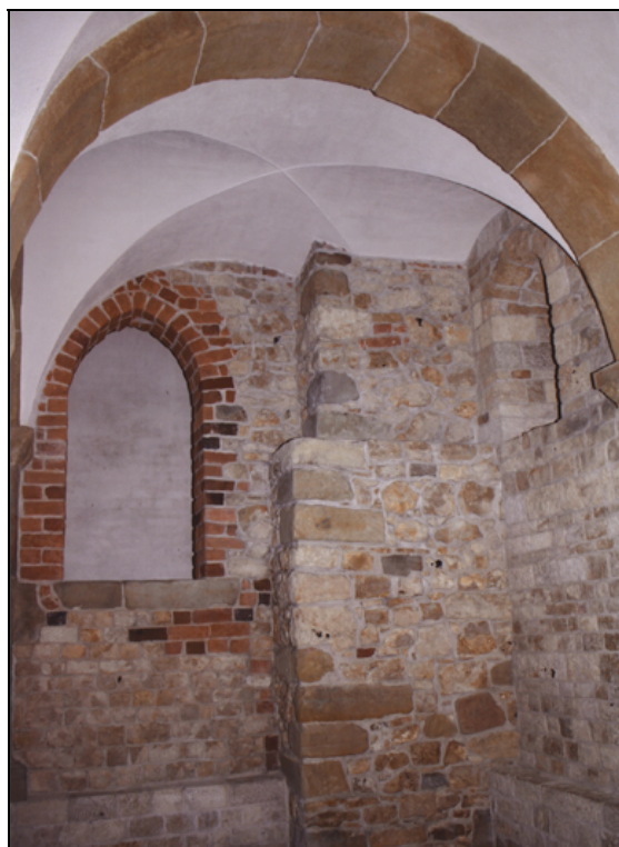
Rys. 10. Południowo-wschodni narożnik krypty. Stan po konserwacji
