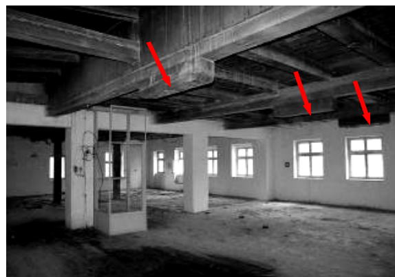
Rys. 7. Usunięte słupy III kondygnacji budynku nr 10
