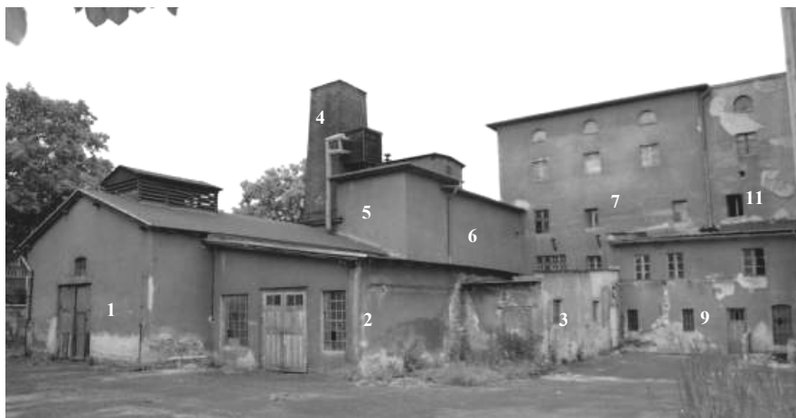
Rys. 2. Widok ogólny dobudówek od strony placu manewrowego Fig. 2. General view of outbuildings
