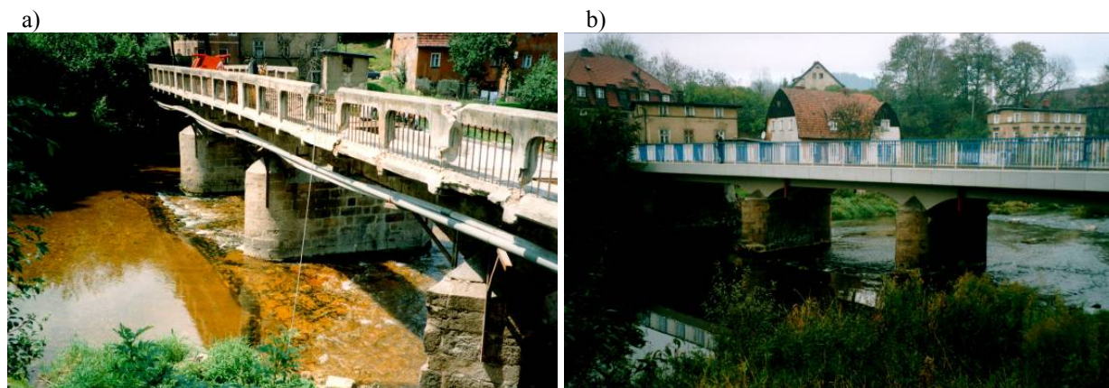
Rys. 4. a) Stan mostu przed rozpoczęciem remontu i wzmocnienia; b) Widok mostu po zakończeniu robót Fig. 4. a) Bridge condition before restoration and strengthening, b) General view of bridge after restoration.
