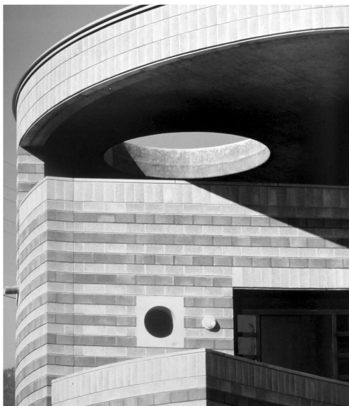
Fot. 16. Casa Bianda, dom w Losone, 1987–1989, detal – układ betonowych bloczków w ścianie
