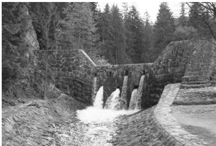
Fot. 3. Widok tamy przy zbiorniku w rejonie Nosala przy średnim stanie wód
