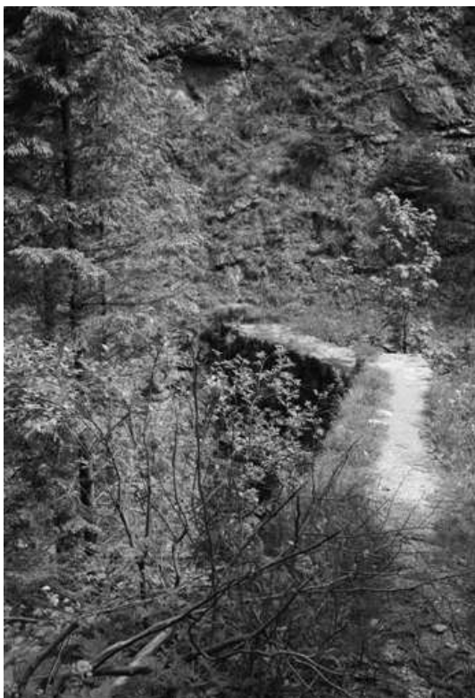
Fot. 1. Widok Korony tamy zamykającej bieg potoku wypływającego z Jaworzynki. Tama jest zlokalizowana na progu doliny; jej wysokość od strony południowego zachodu wynosi 8–10 m
