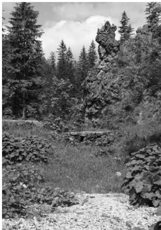
Fot. 2. Widok tamy od strony doliny. Tama niemal całkowicie została przesłonięta naniesionym przez wodę rumoszem skalnym
