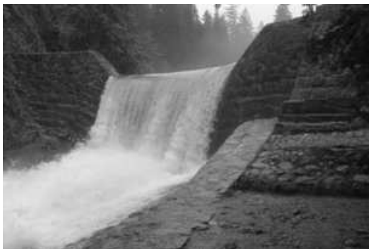
Fot. 4. Widok tamy przy zbiorniku w rejonie Nosala w stanie zagrożenia powodziowego
