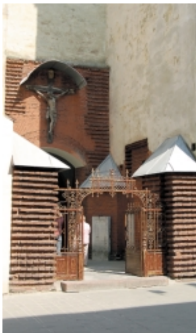
Ryc. 5. Wejście główne do katedry (rozwiązanie zastępcze) Fig. 5. Main entrance to the cathedral (substitute solution)
