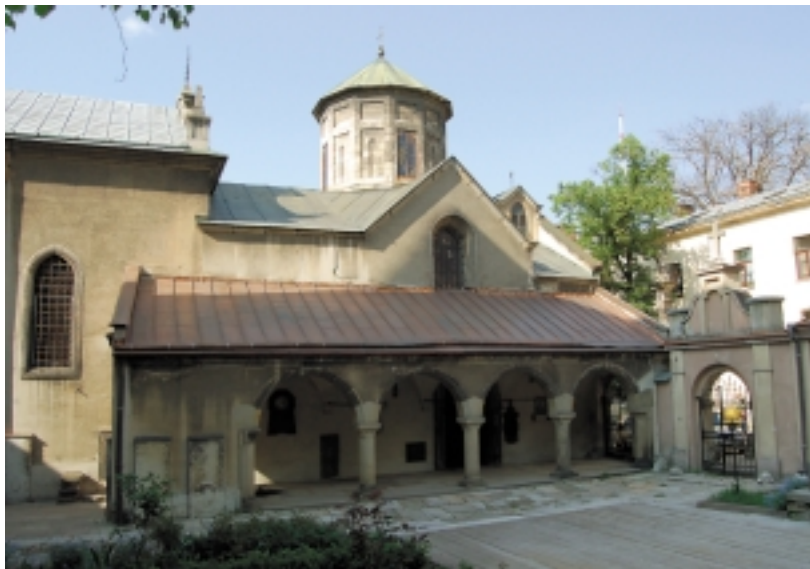
Ryc. 6. Widok od strony południowej Fig. 6. View from the south
