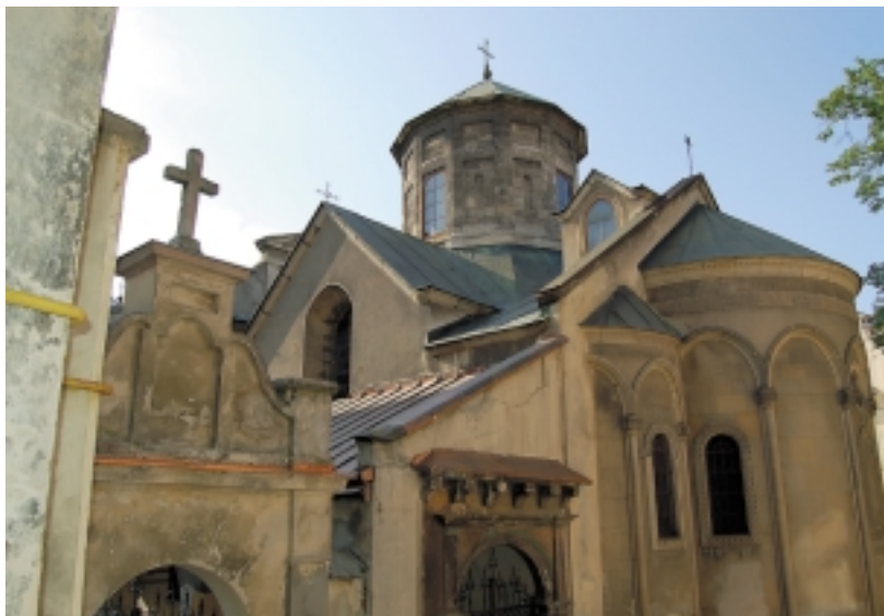
Ryc. 8. Widok na najstarszą część katedry od strony wschodniej Fig. 8. View of the oldest part of the cathedral from the east
