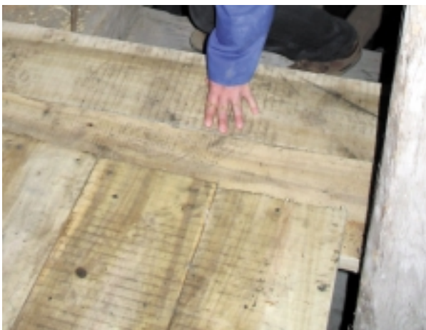
Ryc. 8. Ślady po obróbce trakiem mechanicznym (fot. M. Warchol) Fig. 8. Traces of processing with a frame sawing machine (photo M. Warchol)
