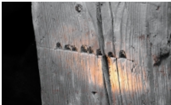
Ryc. 4. Często stosowana forma ciesielskiego znaku montażowego (fot. D. Mączyński)
