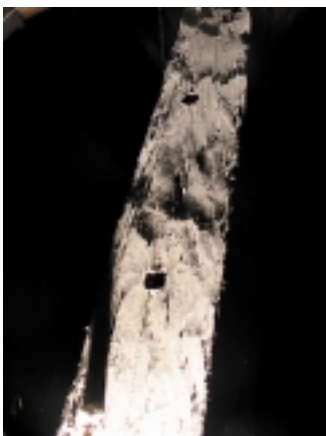
Ryc. 8. Ślady po obróbce trakiem mechanicznym (fot. M. Warchol) Fig. 8. Traces of processing with a frame sawing machine (photo M. Warchol)
